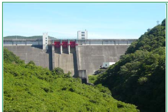
下流から見た吞吐ダム
